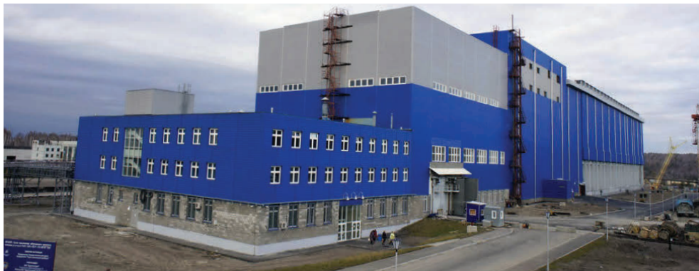
Сухое хранилище ОЯТ на Горно-химическом комбинате
