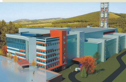
Фасад опытно-демонстрационного центра переработки ОЯТ (ГХК)
