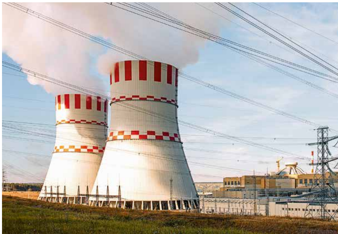
Рисунок 2.8. Градирни (Нововоронежская АЭС)
