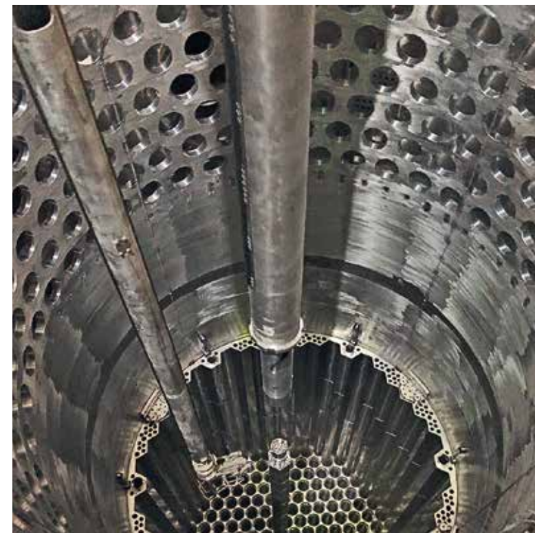
Рисунок 2.7. Корпус реактора ВВЭР со снятой верхней крышкой бака
